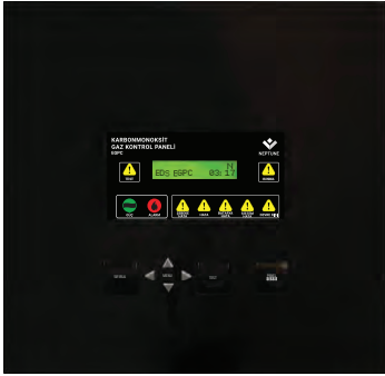
Adreslenebilir Karbon Monoxide Kontrol Paneli EGPC
